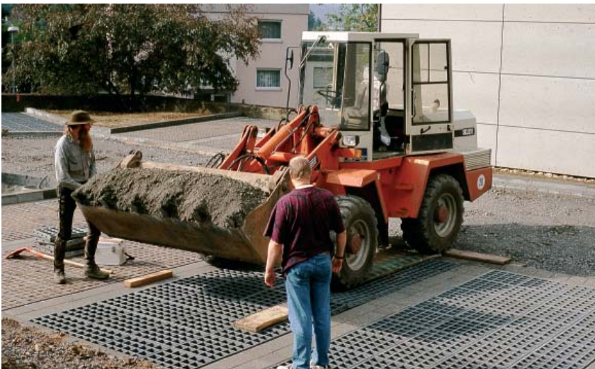
Заполнение швов после укладки на выравнивающий слой толщиной 2-3 см
