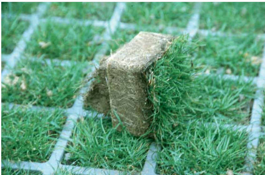
Засыпка и грунтовое основание становятся площадью для разрастания корней.
