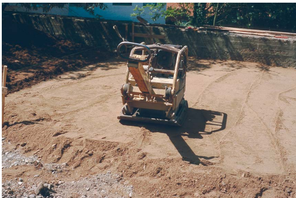
Устройство несвязного грунта на испытываемой площади.
