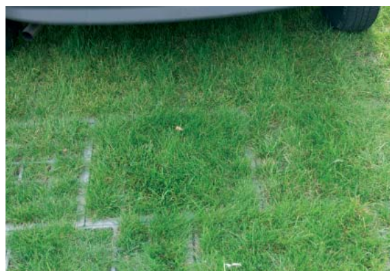
Газонная решетка ТТЕ со смещением стыкового соединения летом 2002 года.
